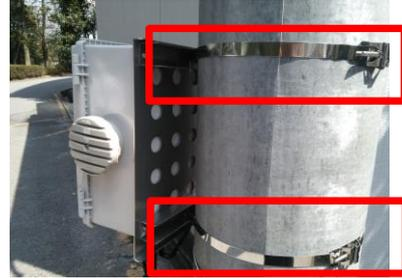
●単管パイプに取付ける場合は付属の単管クランプをご使用ください。背面の金属板を利用する場合は、ステンレスバンドをご用意いただきポールなどの安定した場所へ取付けてください。(図参照)。
