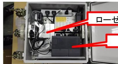
●通信ボックス内へ光回線を入線し、ルーターに接続してください。光回線の詳しい入線方法は付属の光ファイバー施工説明書をご確認ください。
