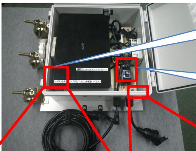
2.UPS装置の電源ボタンを押して、ランプが点灯したことを確認してください。
