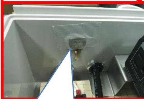
4.内部機器操作後、必ずボックスを閉めて施錠してください。内部右下側面に張り付けてある鍵を使用してください。
